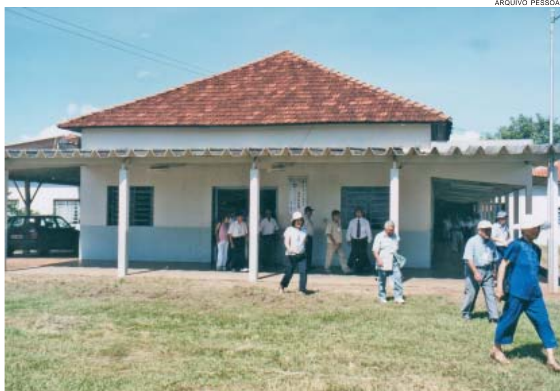
Nova estrutura metálica do kaikan possibilitou ampliação das atividades culturais e recreativas
